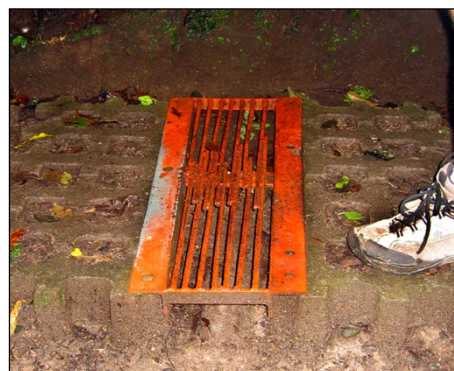
Os blocos permitem utilizar executar obras de proteção nas trilhas, como o caso deste bueiro de águas pluviais.
