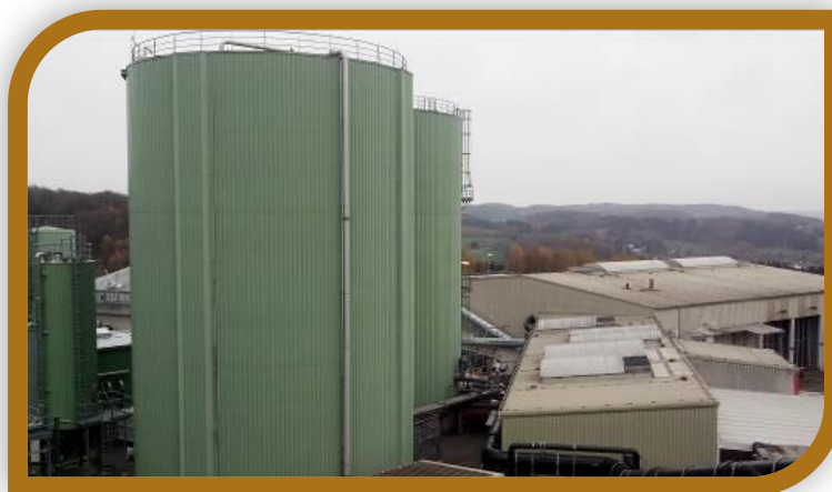
Fotografia 10 – Biodigestores para tratamento de resíduos na Alemanha
