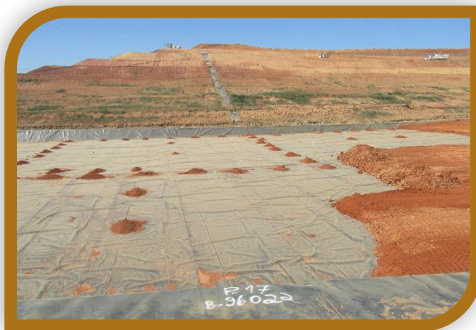
Fotografia 11 – Aterro sanitário em Paulínia/SP
