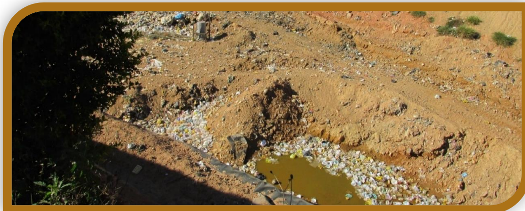
Fotografia 4 – Disposição inadequada de resíduos
