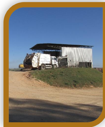
Fotografia 2 - Estação de transbordo
