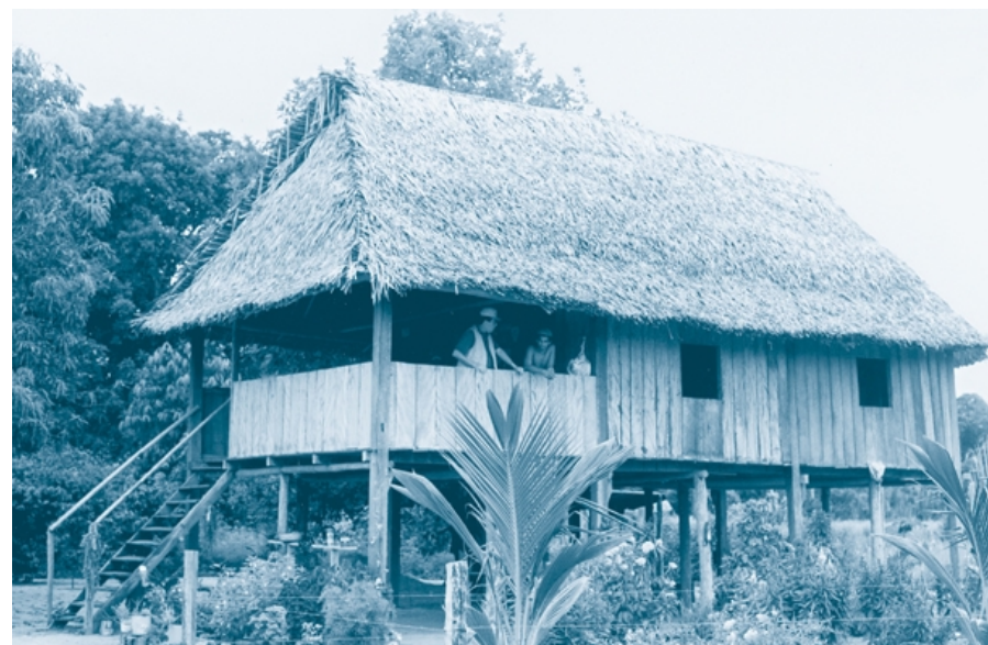
Construção típica de caboclo amazônico, adequada ao clima e regime de chuvas regional e modelo para hotéis de selva, Reserva Extrativista do Rio Ouro Preto, Guajará-mirim, RO
